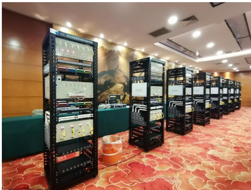
图 11 综合布线系统安装与维护实训室
